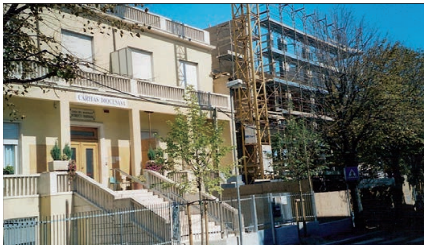
■ Una fase dell'ampliamento per la costruzione della nuova ala Caritas.
